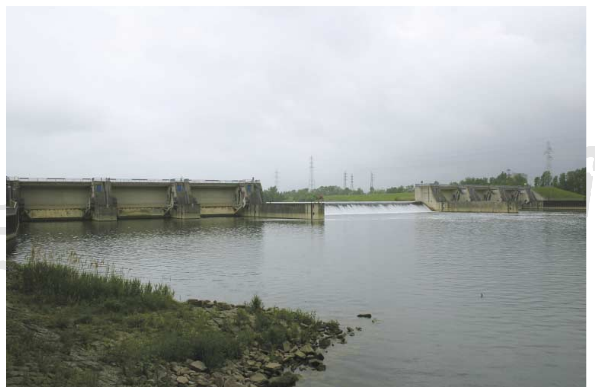
Na obszarze retencyjnym stopnia Kehl/Strassburg istnieje możliwość spiętrzenia wody do wysokości 6 m na powierzchni 700 ha. Pozwala to na zatrzymanie do 37 mln m 3 fali powodziowej. Fot. TnZ/Robert Wawręty
