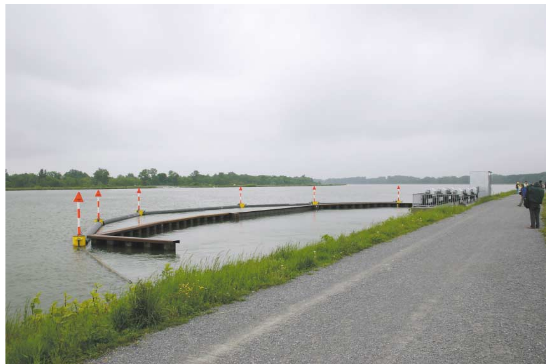
Przepust zewnętrzny poboru wody z Renu na polderach Söllingen/Greffern z pływającymi belkami zabezpieczającymi. Belki zaporowe zapobiegają wciągnięciu łodzi sportowych. Fot. TnZ/Robert Wawręty
