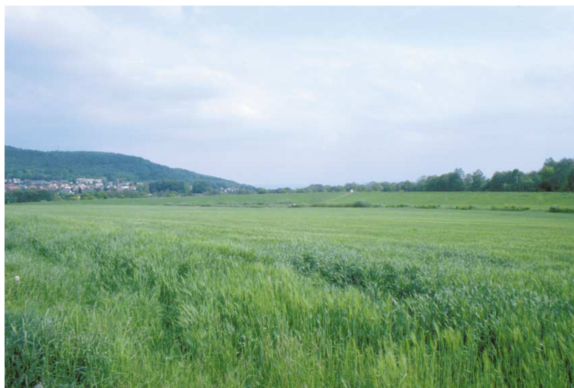
Powstały polder Schefferfeld o pojemności 234 tys. m 3 chroni Baunatal przed wodą stuletnią. Zaczyna się napełniać w momencie, kiedy przepływ w Baunie osiąga wartość powyżej 15 m 3 /s. Fot. TnZ/Robert Wawręty
