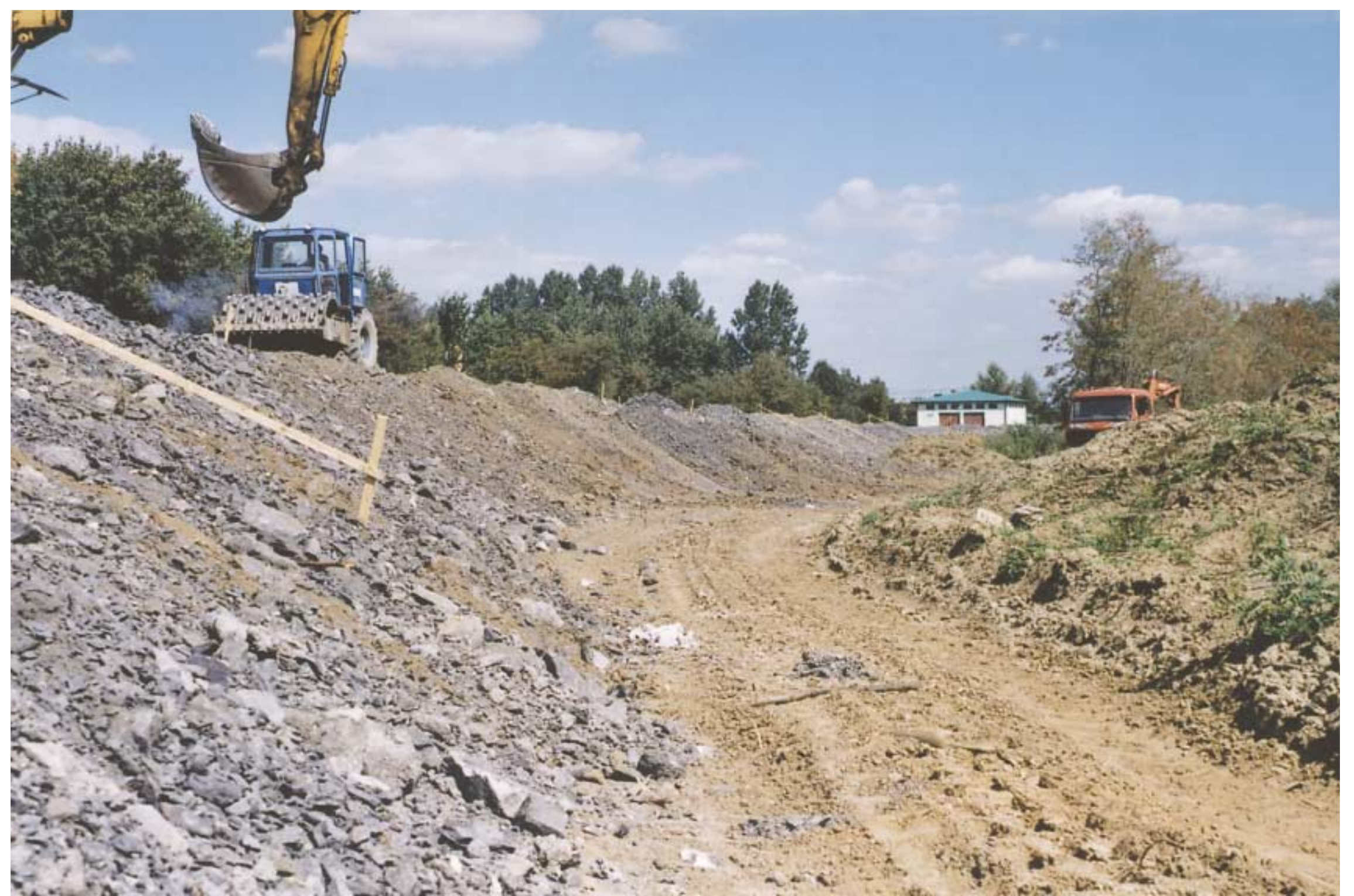
Obwałowania ze skały płonnej stanowią nowe źródło zagrożeń dla ekosystemów nadrzecznych i użytków rolnych w dolinach rzecznych. Stosowanie tego odpadu, powstającego przy wydobyciu węgla, powoduje zakwaszenie i zasolenie gleb oraz zanieczyszczenie metalami ciężkimi. Fot. TnZ/Robert Wawręty
