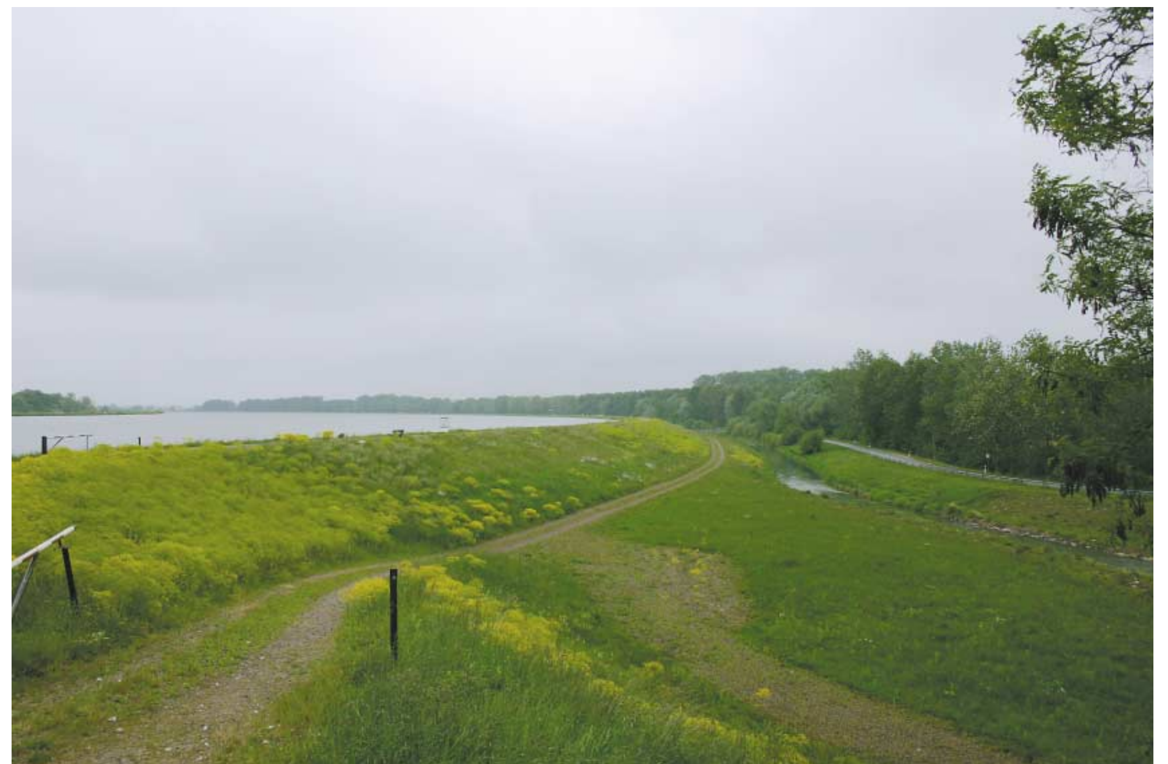
W przypadku wzrastających przepływów wody w Renie poldery zostają zalane dzięki wykonanym w wałach przepustom zewnętrznym. Następnie, z pewnym opóźnieniem czasowym, woda wpływa z powrotem do Renu przez przepust wylotowy, zlokalizowany na dalszym odcinku wału. Poldery Söllingen/Greffern. Fot. TnZ/Robert Wawręty
