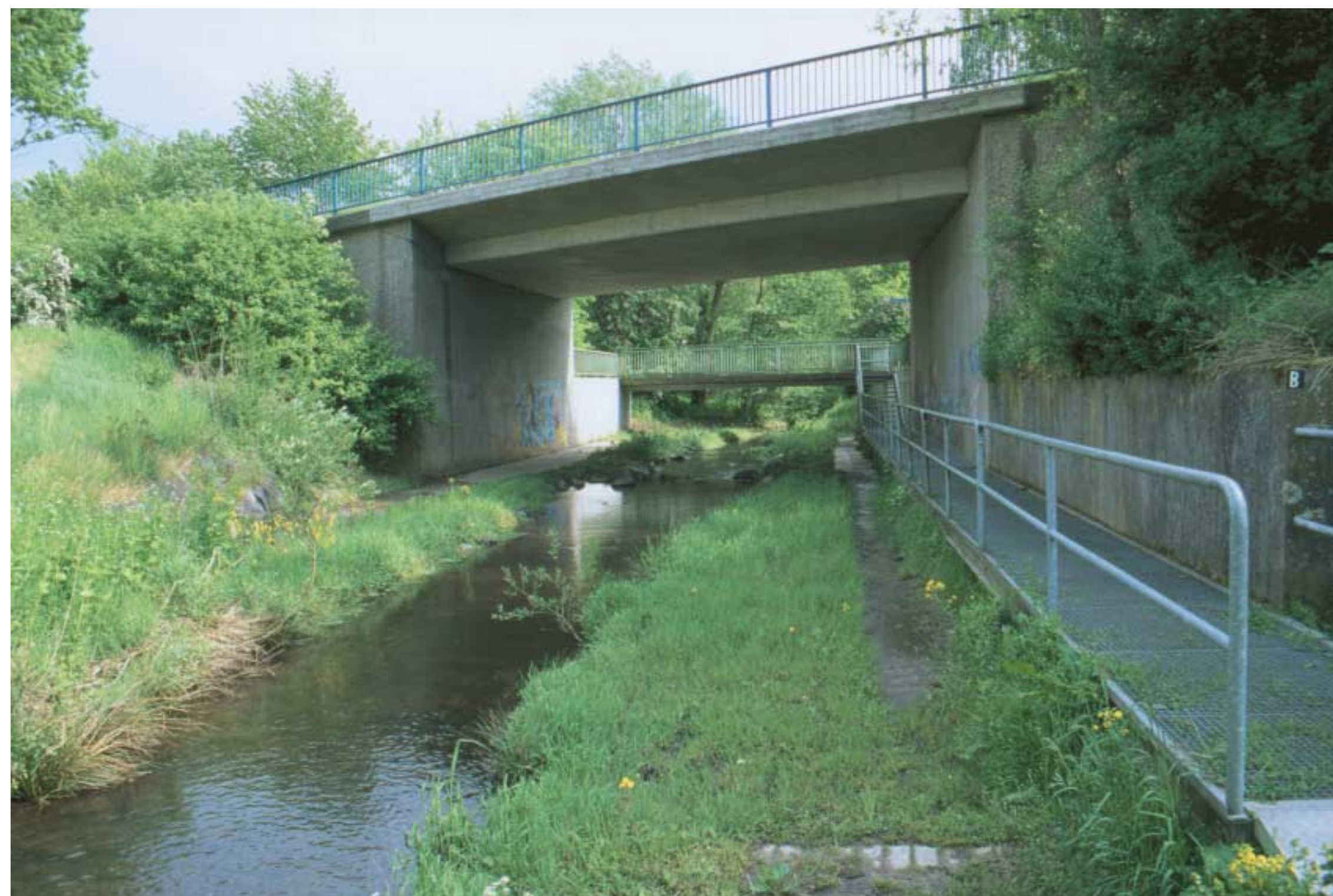
Pretekstem do przeprowadzenia częściowej renaturyzacji Bauny była poprawa bezpieczeństwa powodziowego. Prace polegały na zerwaniu betonowych umocnień, wyprofilowaniu trapezoidalnego przekroju koryta w kierunku zbliżonego do naturalnego oraz usunięciu dwóch progów betonowych. W ramach ochrony przeciwpowodziowej podniesiono kładkę dla pieszych o 50 cm, w celu ułatwienia spływu wody. Fot. TnZ/Robert Wawręty
