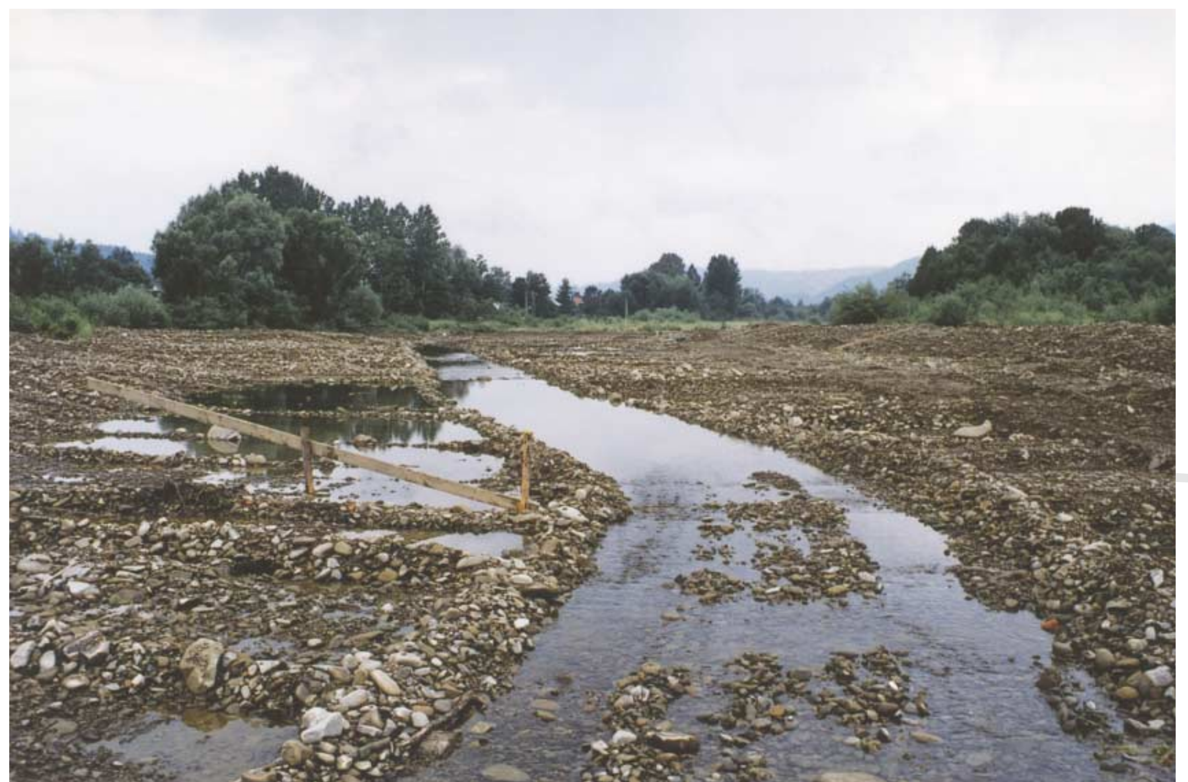
W trakcie regulacji Koszarawy rzeka została przekorytowana (przesunięta) na kilkadziesiąt metrów względem pierwotnego biegu. Po szerokiej na kilkadziesiąt metrów rzece pozostała jedynie mała, leniwie płynąca struga. Fot. TnZ/Robert Wawręty
