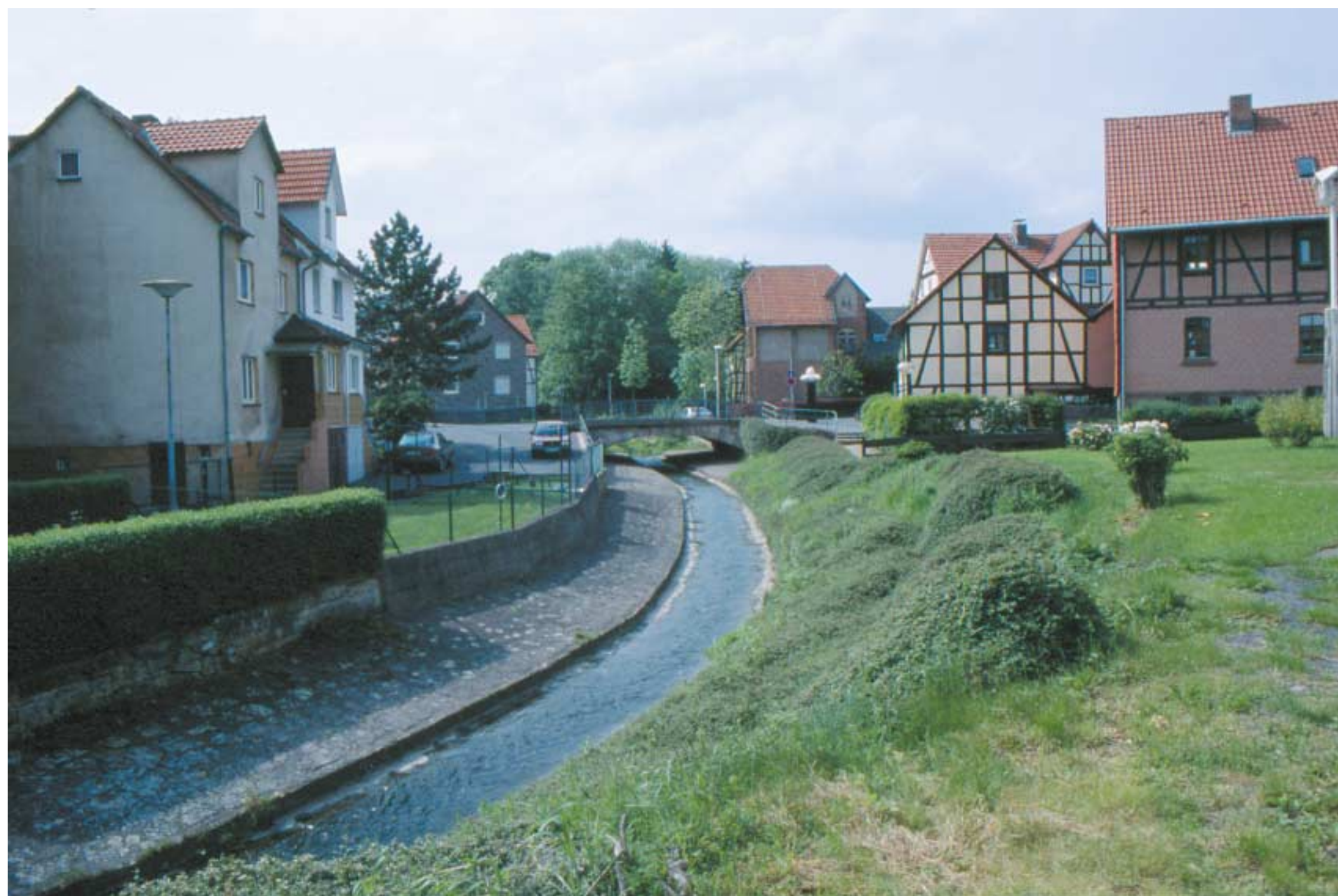
Przed renaturyzacją potok Bauna przypominał betonową rynną odprowadzającą wodę. W efekcie regulacji fale powodziowe stały się bardziej strome i wzrosła ich kulminacja. Fot. TnZ/Robert Wawręty
