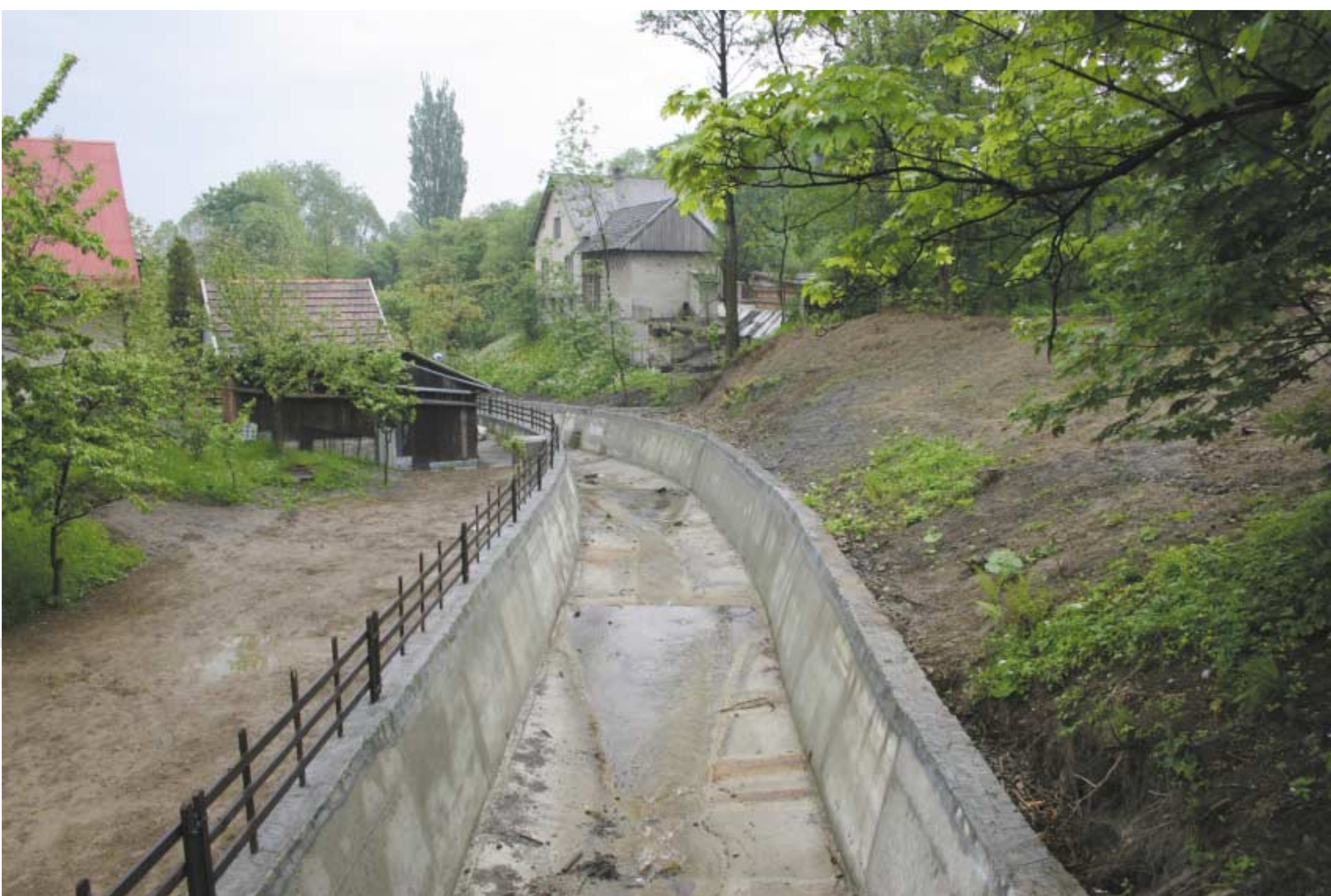
Skrajny przypadek regulacji prowadzącej do całkowitej zagłady życia biologicznego. Betonowych żłobów już od dawna nie wykonuje się w Niemczech, a mimo to w Polsce nie potrafimy odejść od ich stosowania. Fot. TnZ/Robert Wawręty
