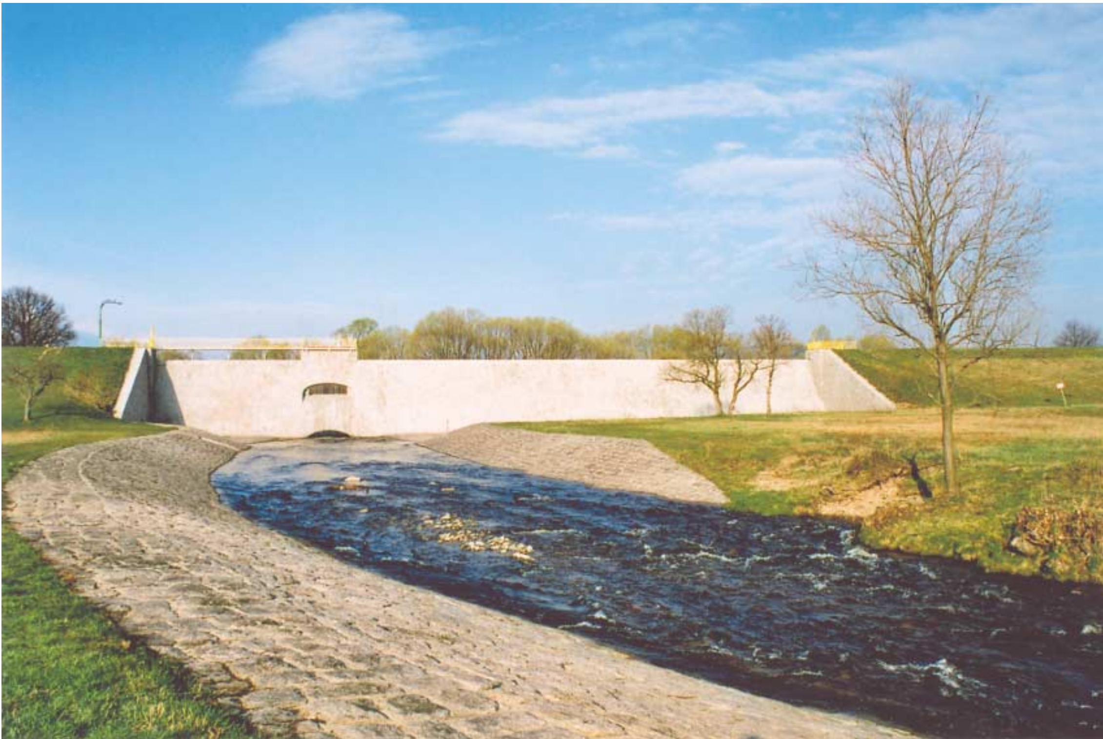
Suche zbiorniki stanowią skuteczną ochronę przed powodzią i zarazem są mało inwazyjne dla środowiska. Z punktu widzenia oddziaływania na środowisko, wątpliwość może budzić estetyka budowli i fragment uregulowanego brzegu poniżej zbiornika. Fot. KPN/Andrzej Raj
