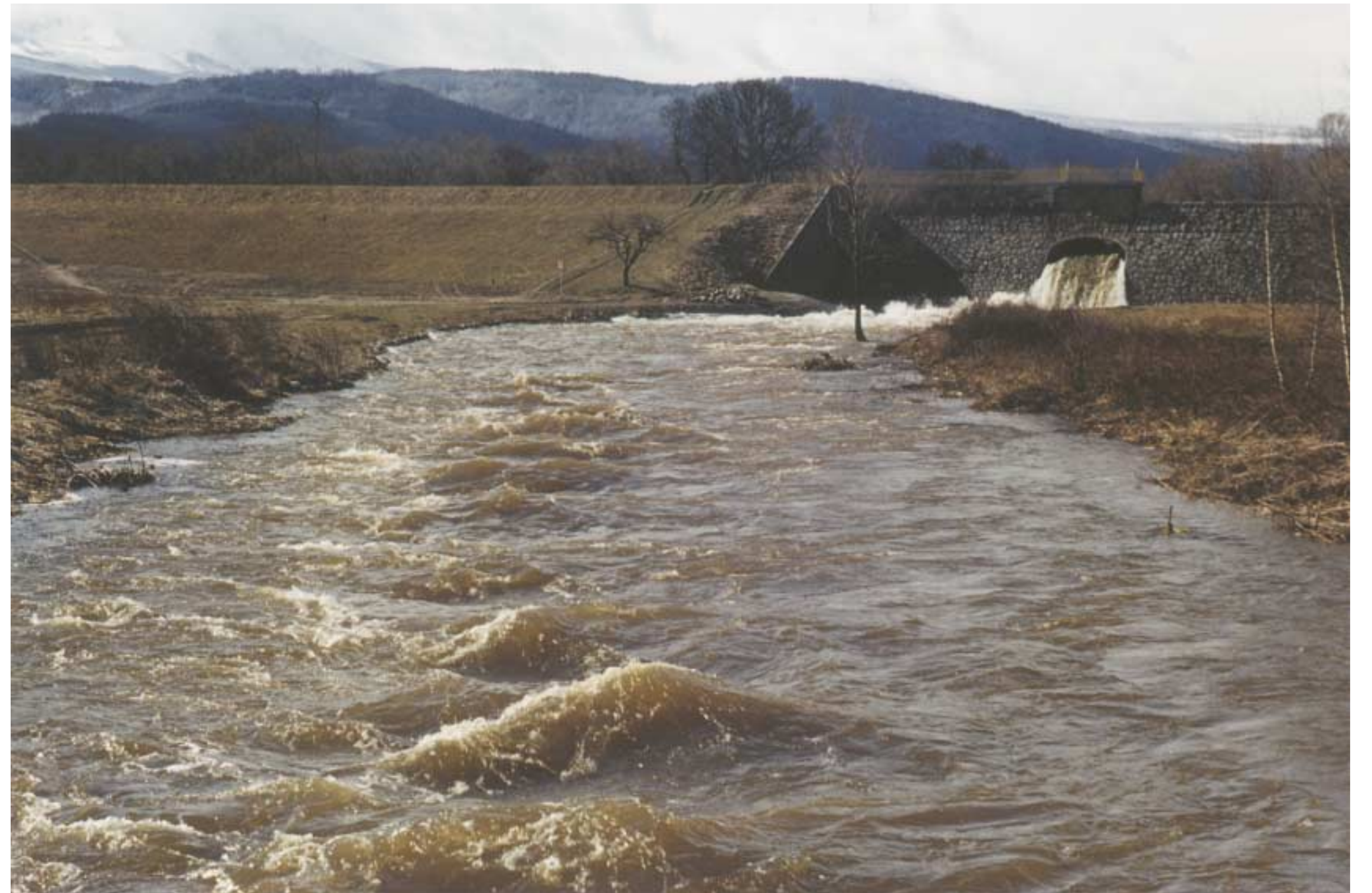
Suchy zbiornik zostaje wypełniony dopiero przy wysokim stanie wody i następnie samoczynnie ulega opróżnieniu. Fot. KPN/Barbara Wieniawska
