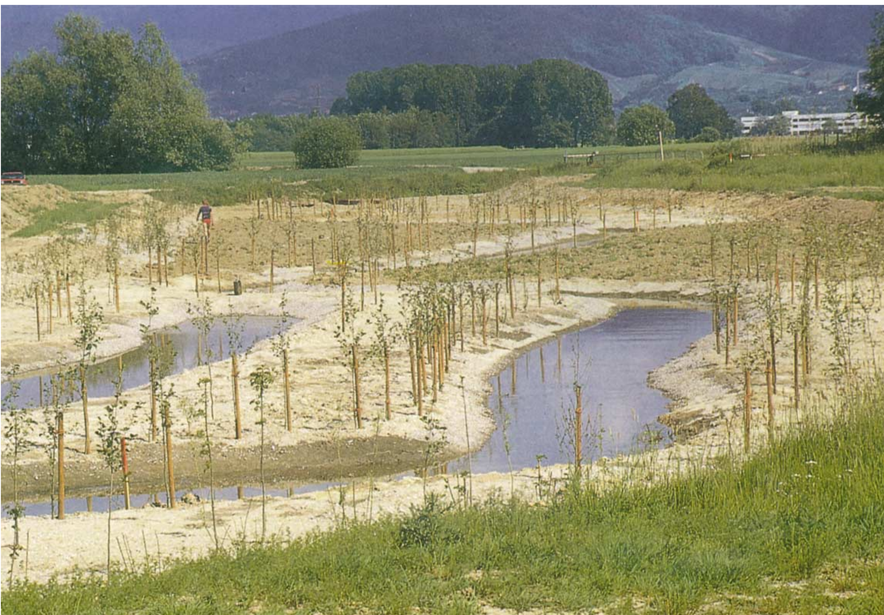
Po wykonaniu poszerzenia (max do 50 m szer.) terasy zalewowej i koryta, na brzegach nasadzono pojedyncze olsze. Takie ukształtowanie Kleines Sulzbächle umożliwia przejmowanie większego czoła fali powodziowej i swobodne kształtowanie przez ciek swojego biegu, w założonym pasie szerokości. Ponadto pozwala na zachowanie krajobrazu otwartych łąk. Fot. Zink Ingenieure GmbH
