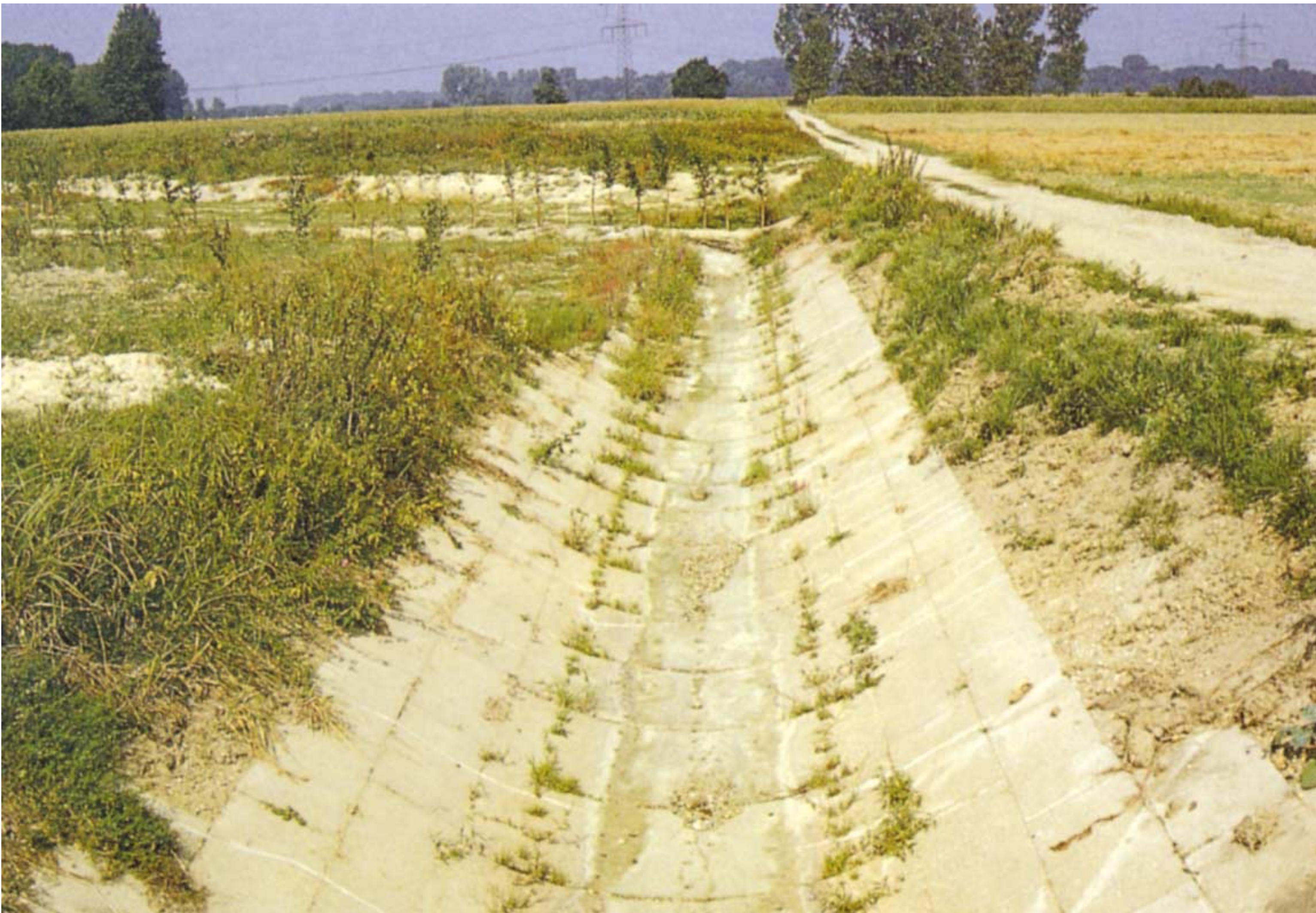
Przed renaturyzacją Kleines Sulzbächle był prostoliniową rynną o przekroju trapezu, wyłożoną betonowymi płytami. Fot. Zink Ingenieure GmbH
