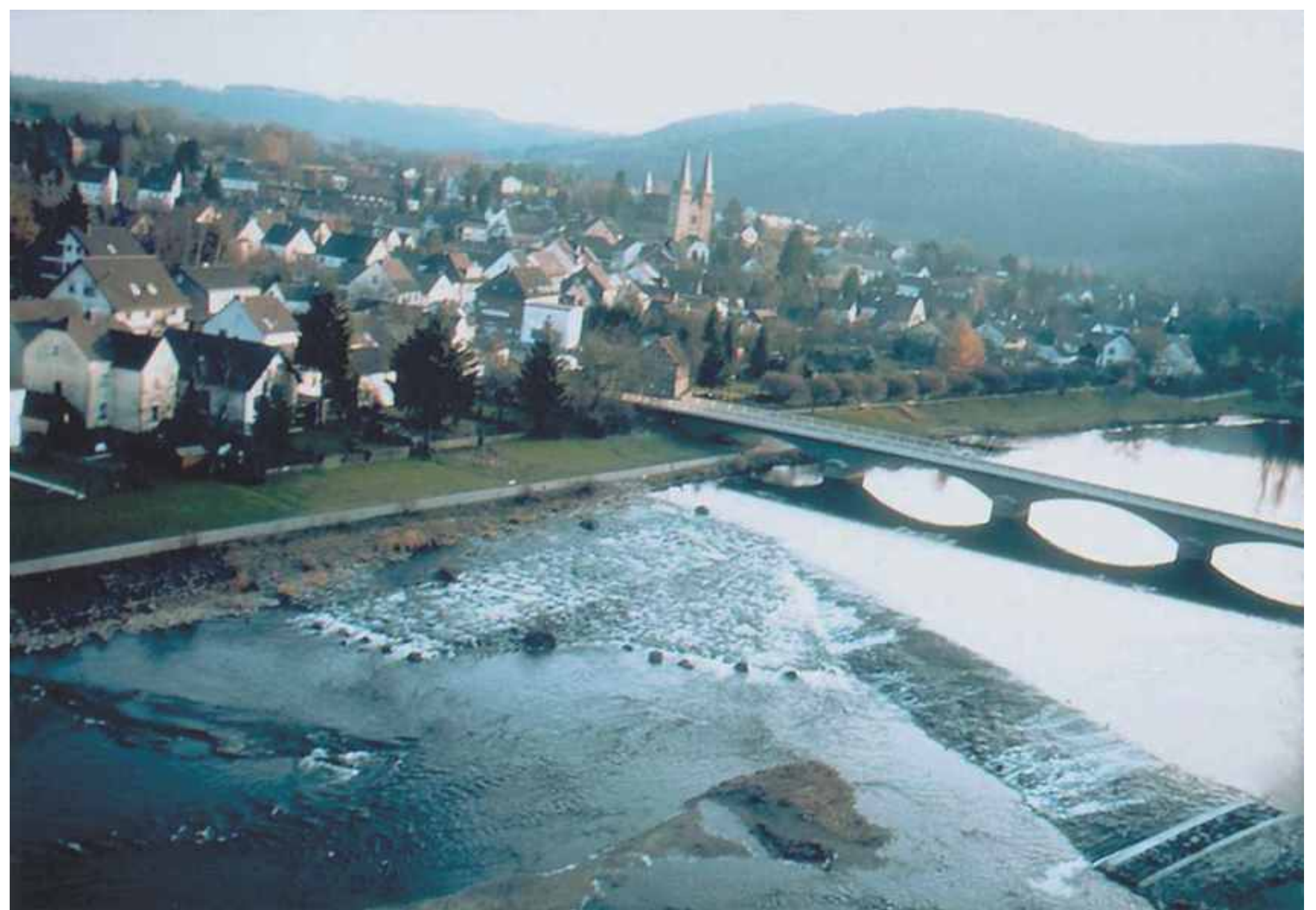
Modelowy przykład dobrze wykonanej przepławki typu bystrze (rampa) na rzece Sieg w miejscowości Windeck-Dattenfeld w Niemczech. Fot. Gerd Marmulla
