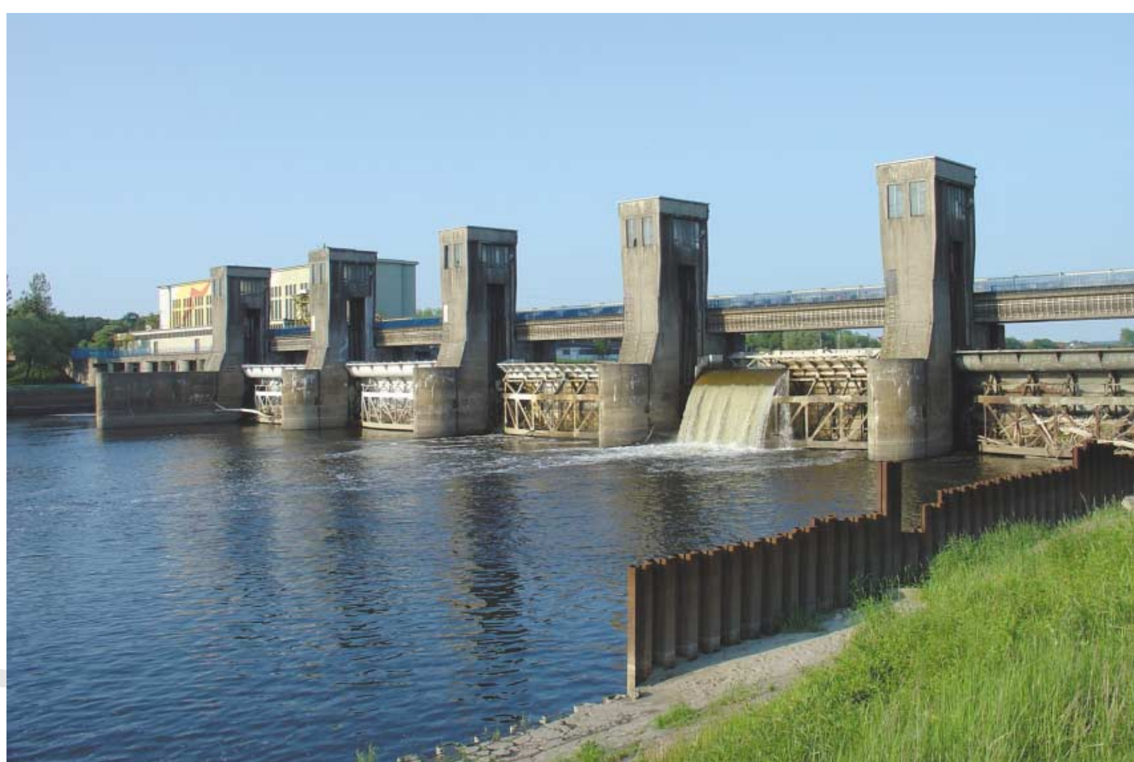
Eksplotacja stopnia wodnego w Brzegu nad Odrą powoduje na 20-kilometrowym odcinku rzeki, pomiędzy Brzegiem Dolnym a Malczycami, silną erozję dna koryta (około 5 cm/rok). Na powierzchni ok. 2000 ha następuje obecnie drastyczne obniżanie się poziomu wód gruntowych. Fot. DFE/Krzysztof Smolnicki
