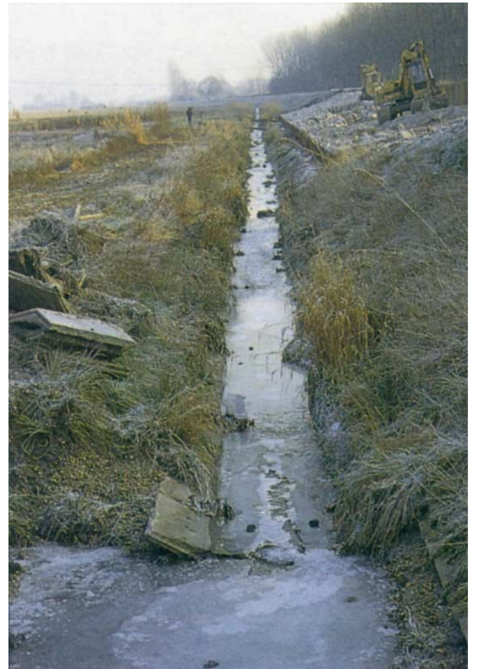
Renaturyzację Kleines Sulzbächle rozpoczęto od usunięcia betonowych umocnień z jego koryta. Fot. Zink Ingenieure GmbH
