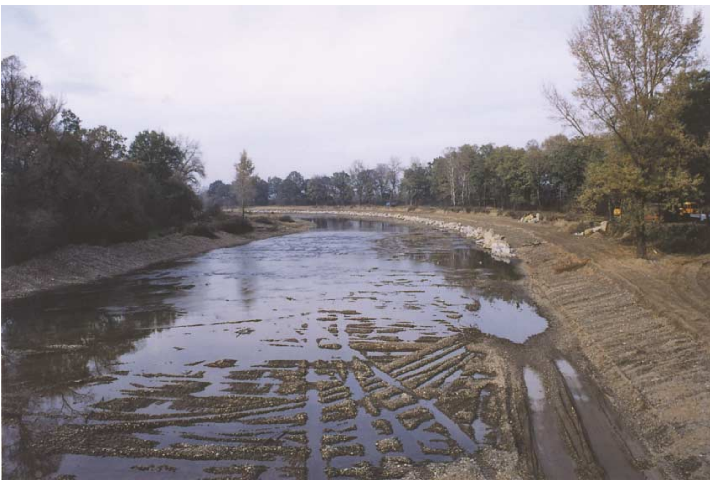
W trakcie regulacji miejsce zróżnicowanego koryta ze stromymi skarpami zostaje zastąpione narzutem kamiennym. Urozmaicone dotychczas licznymi wysepkami staje się rynną odprowadzającą wodę. Fot. TnZ/Robert Wawręty
