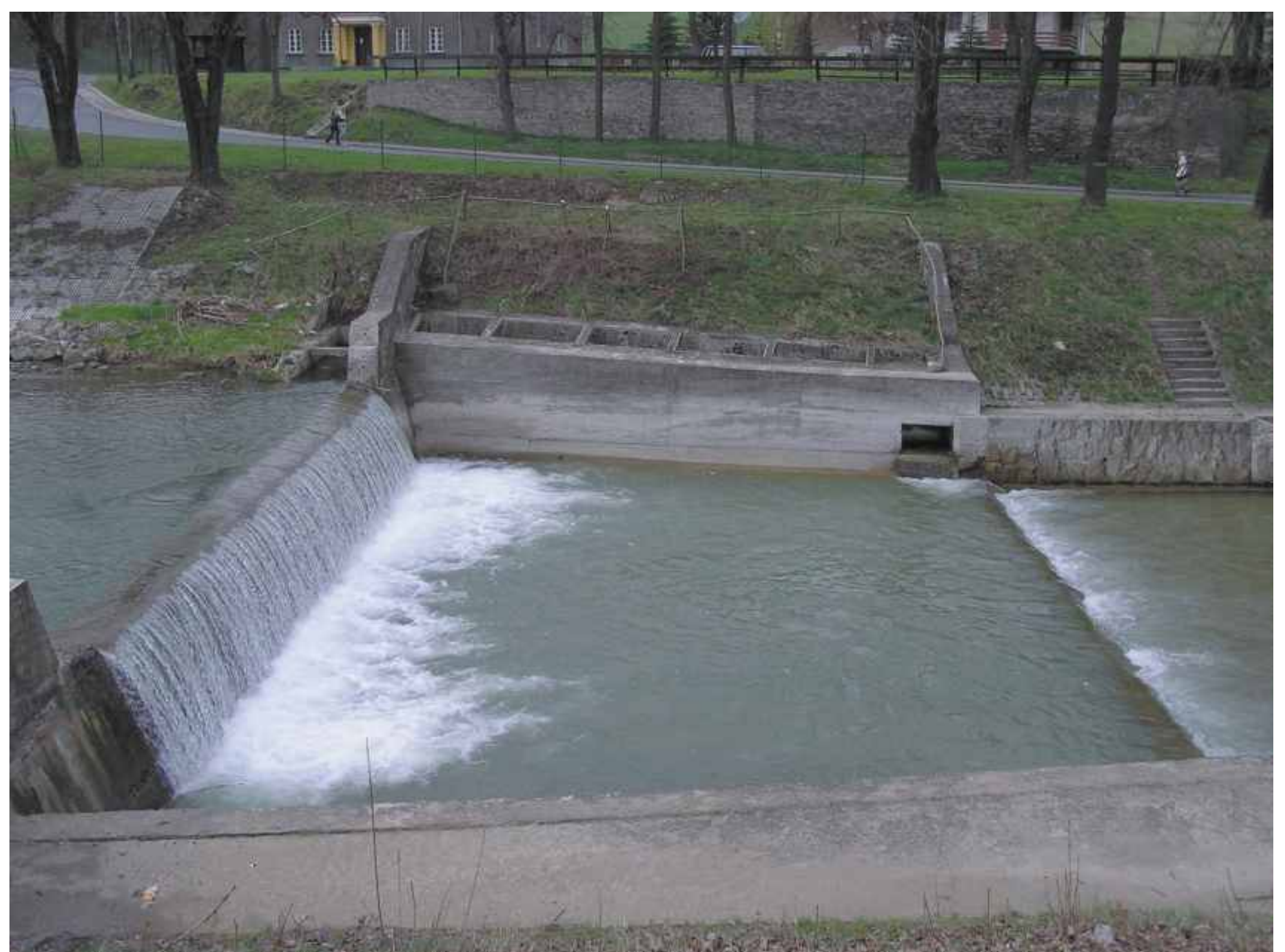
Fatalnie zaprojektowana atrapa przepławki komorowej na rzece Biała Tarnowska w miejscowości Grybów. Głębokość warstwy wody na wyjściu z przepławki wynosi kilka cm, co uniemożliwia wejście ryb do przepławki (od wody dolnej) oraz świadczy o niebywalej beczmyślności i niekompetencji projektanta. Fot. Marek Jelonek
