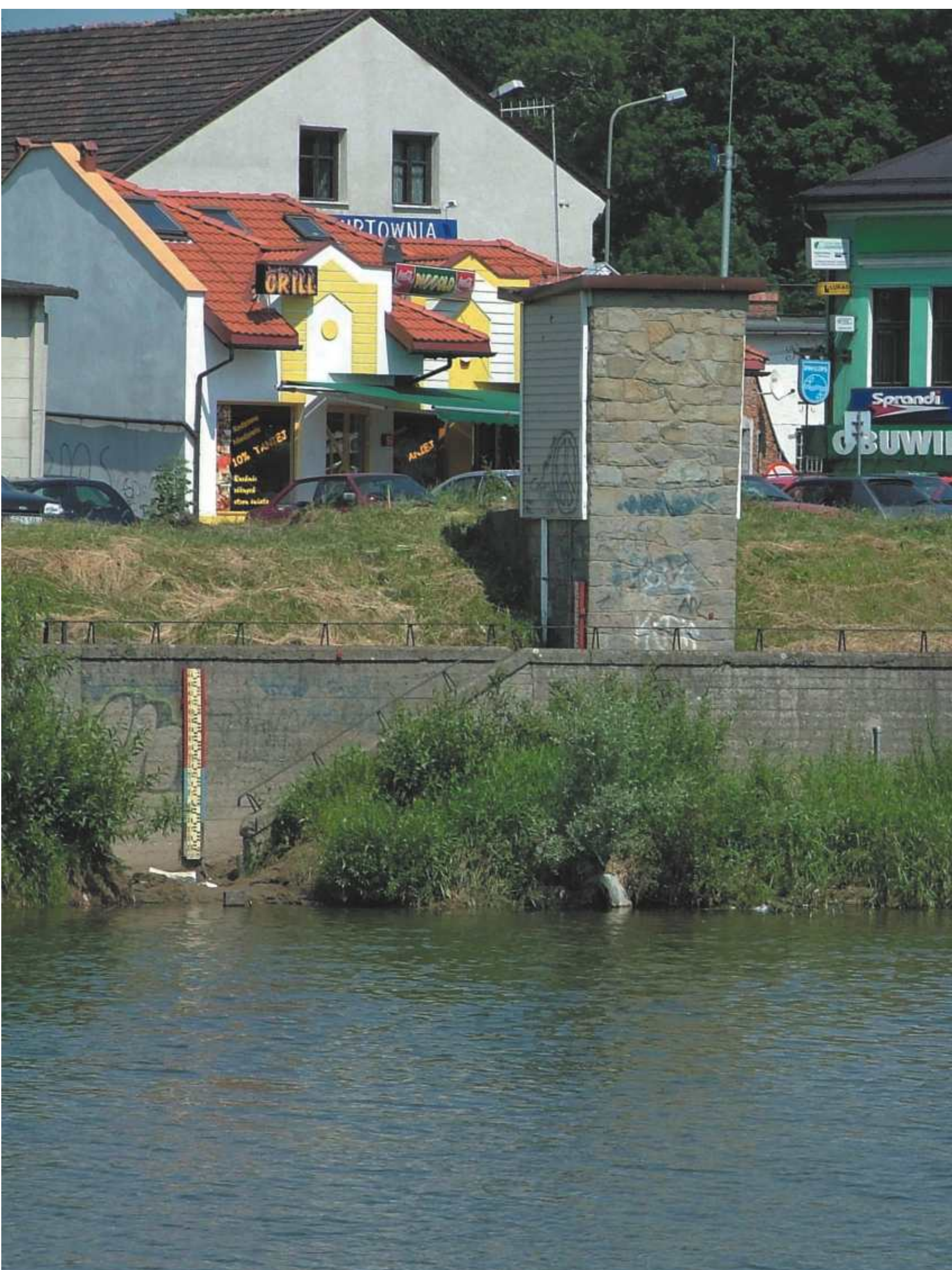
Potrzebę rozwoju lokalnych systemów ostrzeżeń powodziowych zaczyna dostrzegać się również w Polsce. Na zdjęciu widoczny posterunek automatycznej stacji pomiaru poziomu wody w rzece funkcjonujący w ramach takiego systemu dla powiatu żywieckiego. Fot. Arch. powiatowego centrum reagowania kryzysowego w Żywcu
