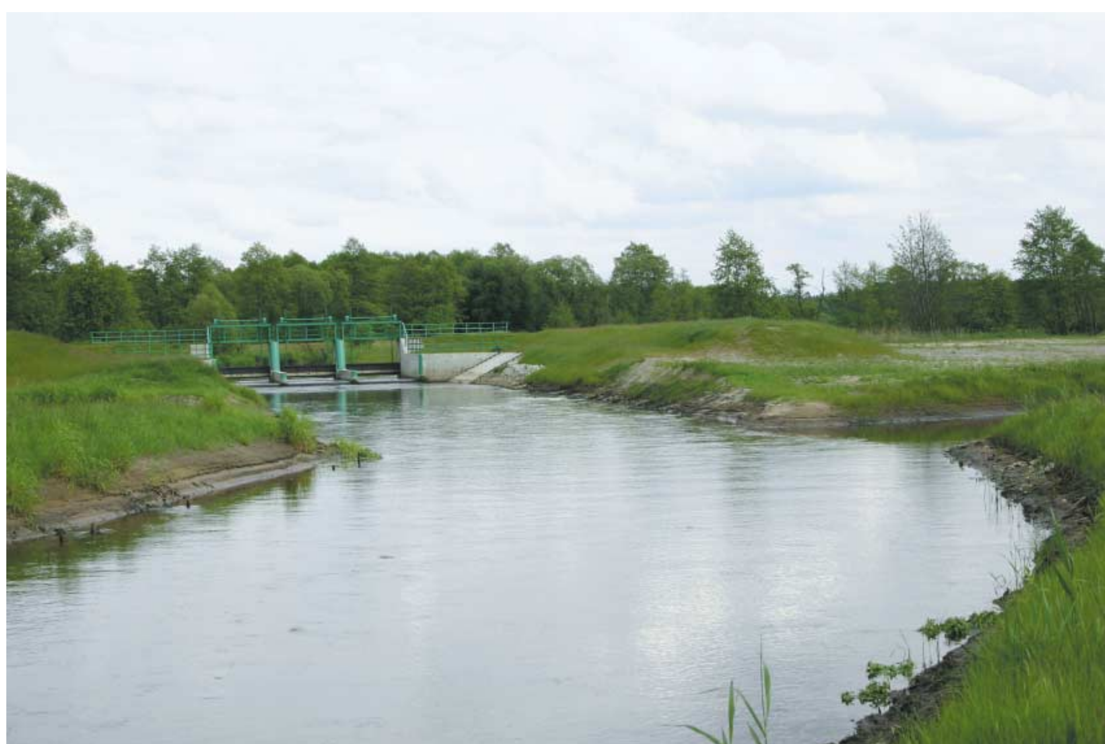
Napełnienie zbiornika następuje wskutek zamknięcia jazu. Wówczas woda, poprzez prawostronne starorzecze i kanał dopływowy zostaje doprowadzona do zbiornika, gdzie następuje jej magazynowanie. Fot. TnZ/Robert Wawręty
