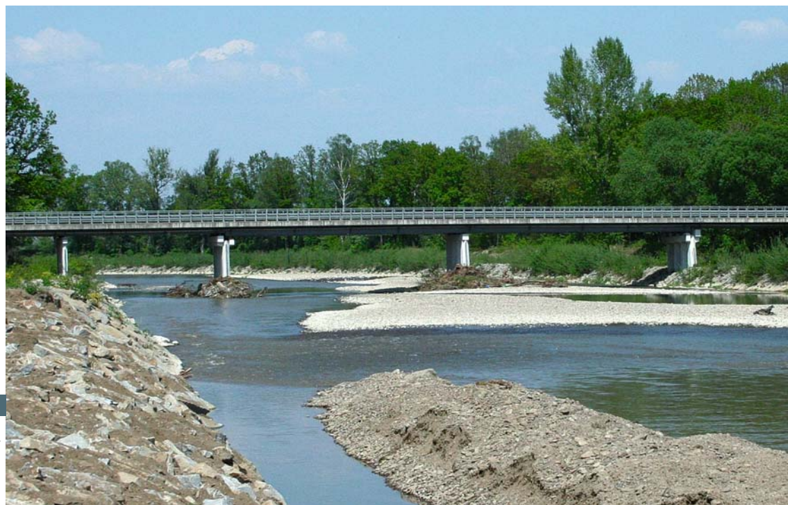
Odślonięte filary mostu na Sole w Łękach w gminie Kęty. Fot. P. Rymarowicz
