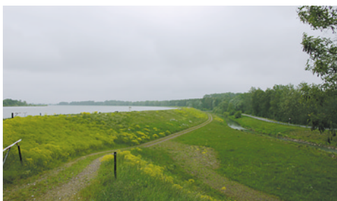
W przypadku wzrastających przepływów wody w Renie polder zostaje zalany poprzez wykonane w wałach przelewy. Poldery Söllingen/Greffern.
