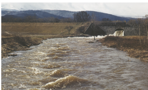
Suchy zbiornik zostaje wypełniony dopiero przy wysokim stanie wody i samoczynnie ulega opróżnieniu.
